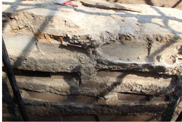
Figura 23 Parete di loculi – catacomba di Santa Ciriaca
