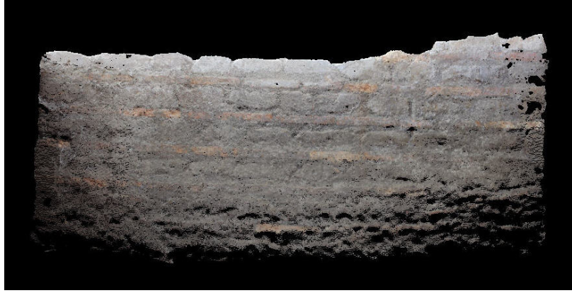
Figura 18 Nuvola di punti del rivestimento parietale in opera mista – catacomba di Santa Ciriaca
