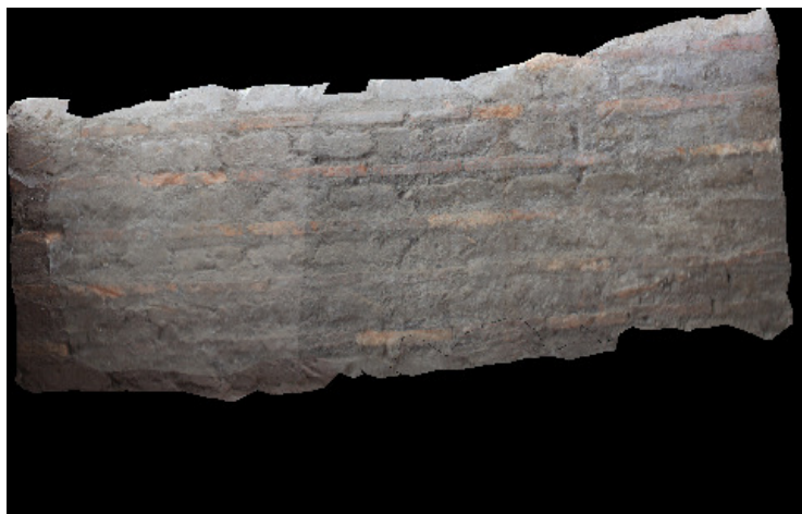
Figura 20 Ortofotomosaico del rivestimento parietale in opera mista – catacomba di Santa Ciriaca
