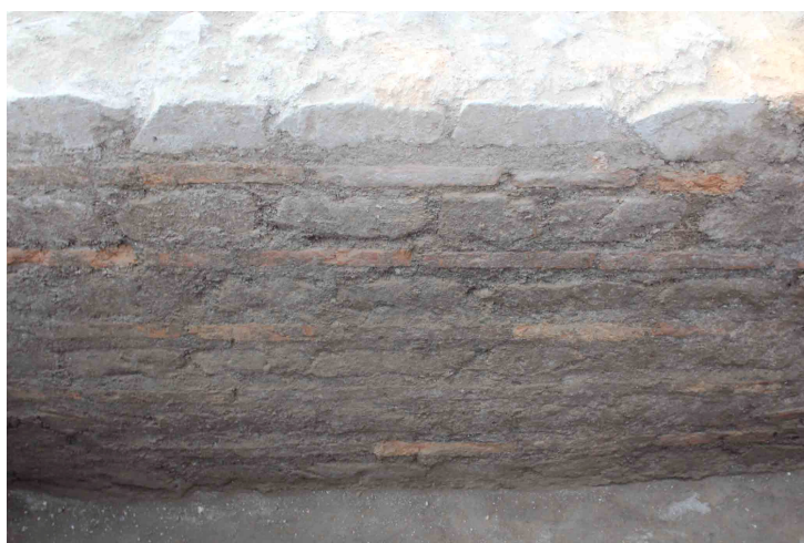
Figura 17 Rivestimento parietale in opera mista – catacomba di Santa Ciriaca
